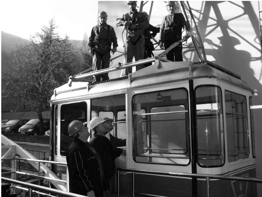
Kabin üzerinde bakım ve kilit açma çalışması
