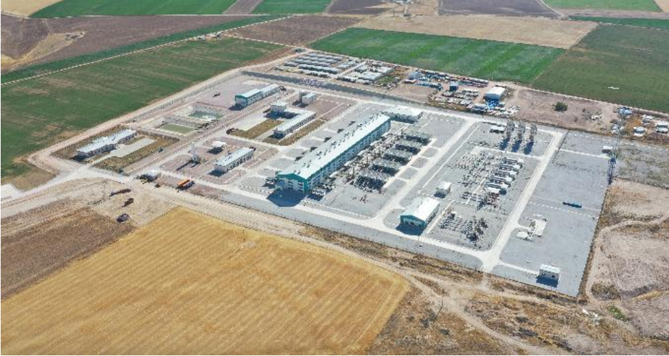
Şekil 6.5 BOTAŞ Tuz Gölü Yeraltı Depolama Tesisi [10]
