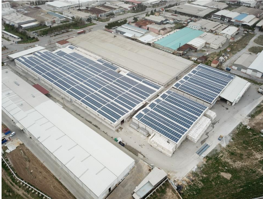
Şekil 6: Denizli İlinde Uygulanan Çatı Tipi PV Sistem
