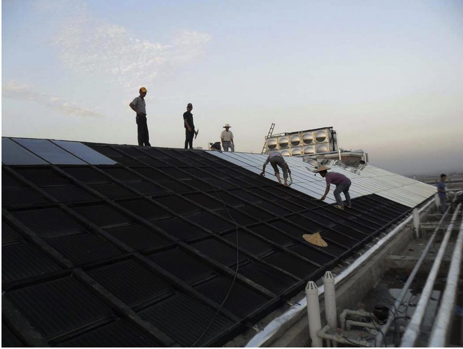
Şekil 10. Seramik güneş kolektörünün çatıya entegrasyonu [14]
