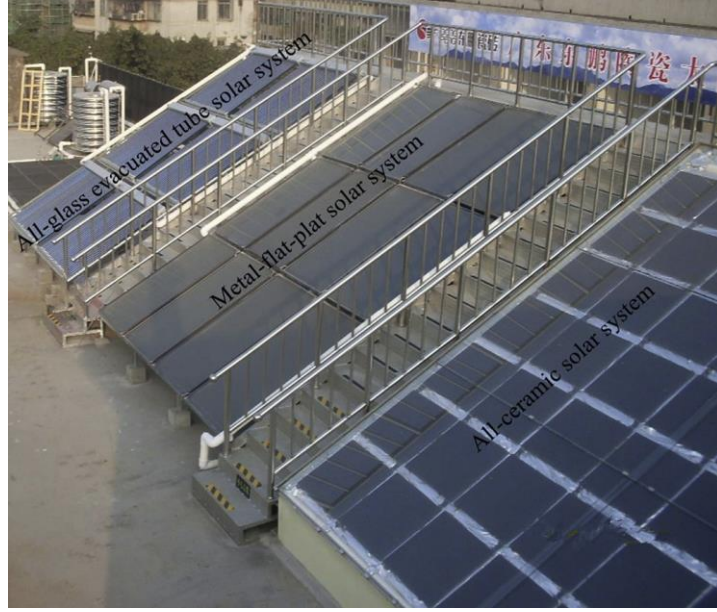
Şekil 7. Denede kullanılan, soldan sağa, vakum tüplü, düz plakalı ve seramik güneş kolektörleri. [9]
