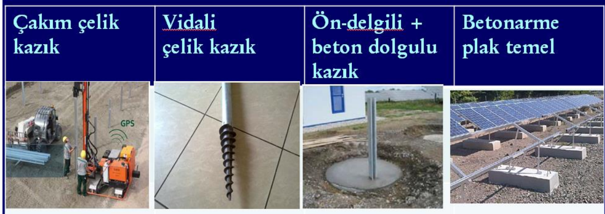
Şekil 4. Saha konstrüksiyonlarında zemine sabitleme işlemleri
