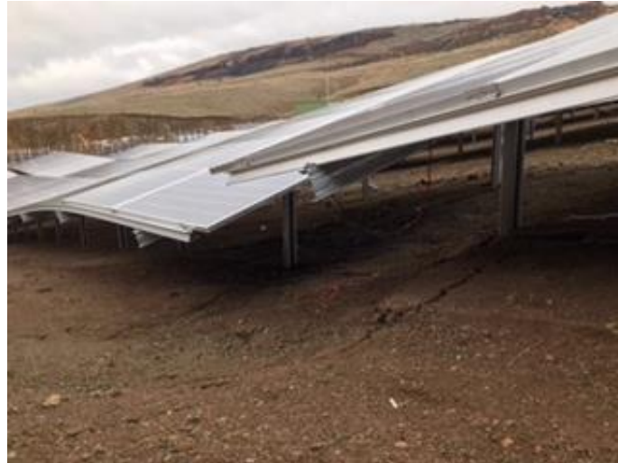
Şekil 6. Dolgu zemin üzerine inşaat
