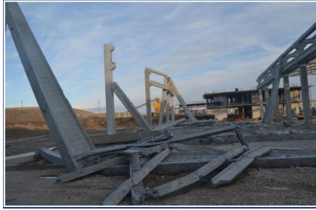
Ŗekil 9. Deprem telenmesinden kaynaklı makas dŖmesi
