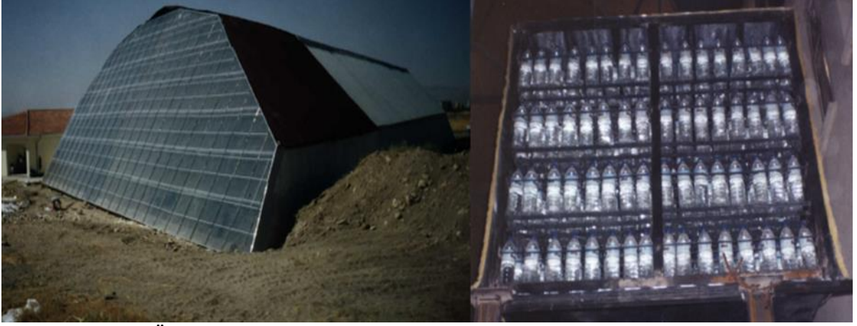
Şekil 4: Erciyes Üniversitesinde kurulmuş olan güneş enerjili spor salonu ısıtma sistemi [4]
