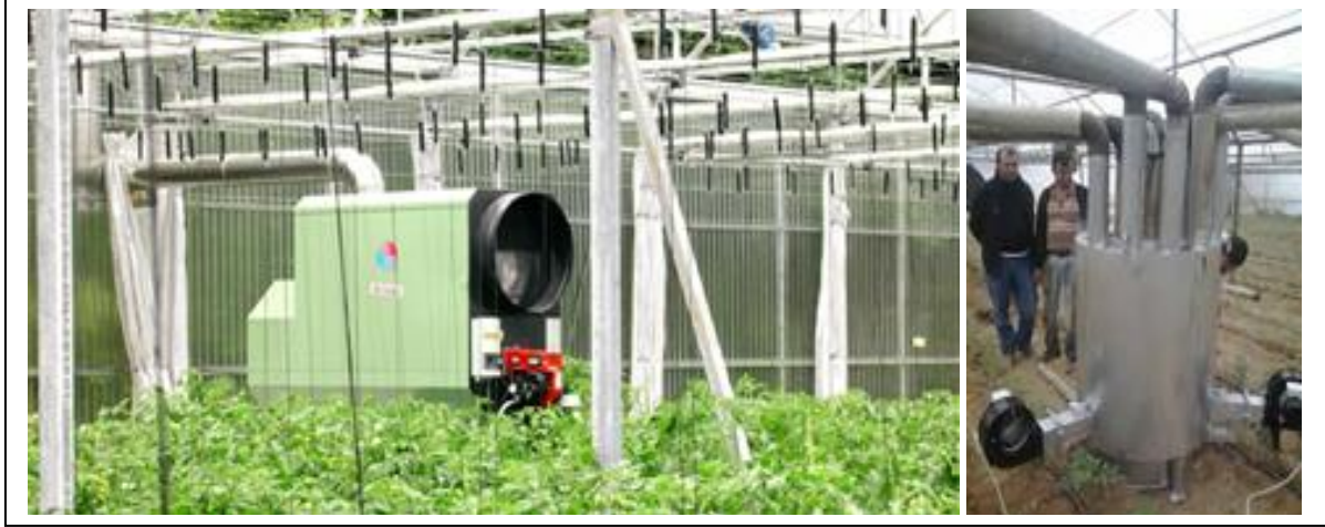
Şekil-2 katı yakıtlı ve çoklu vantilatör kullanılan bireysel sera ısıtma sistemleri
